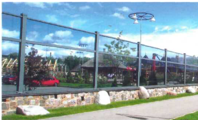
Operas Jaunā zāle ar skaņu izkliedējoši atstarojošām sienu un griestu sistēmām (būvniecības stadijā).
